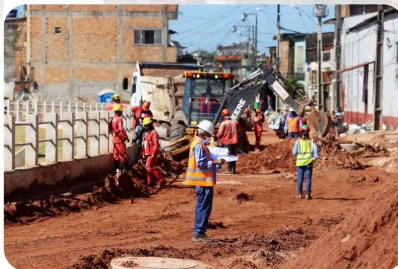
Obras de engenharia
